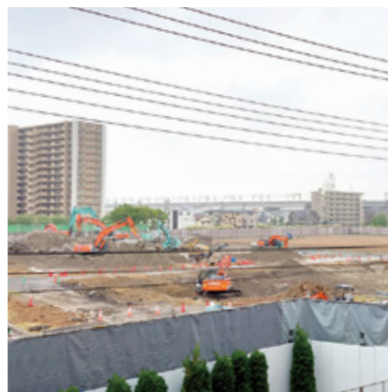
▲大型物流施設建設予定地(5月13日撮影)
